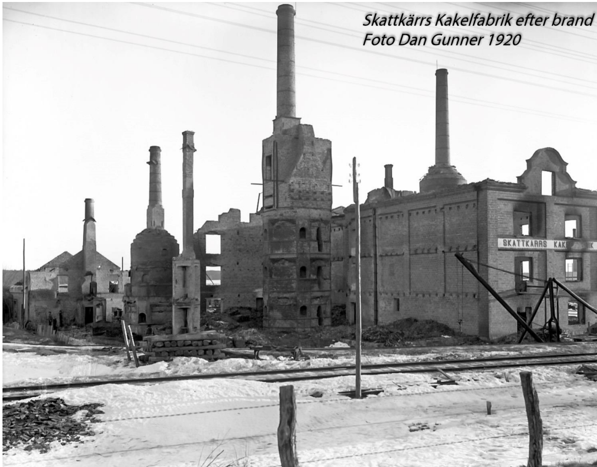
Resterna av Skattkärrs kakelfabrik efter branden 1920. Foto: Dan Gunner.
